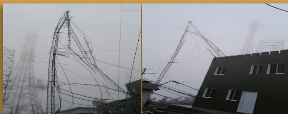
Condiciones previas a la renovación en Alto Bandera
